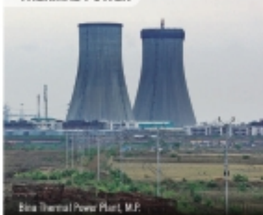
Bina Thermal Power Plant, M.P.
